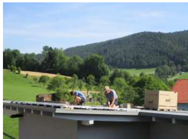
Die Arbeiter der Fa. Eisenhuber bei der professionellen Montage der einzelnen Module
